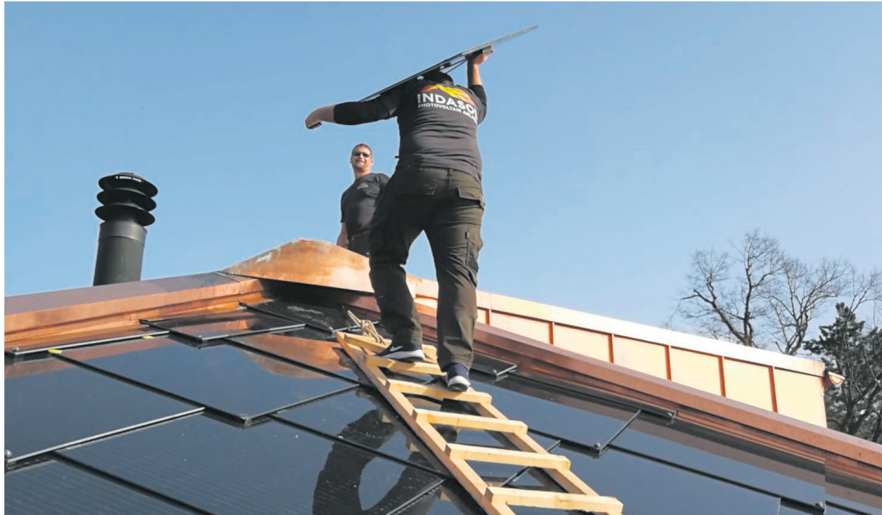
Mitarbeiter von Indasol installieren eine Indach-Solaranlage
